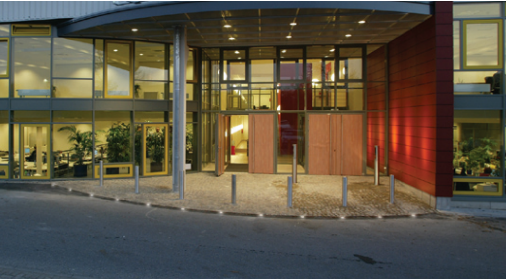
ACO DRAIN® Mobilcom-yrityksen sisäänkäynnin edessä Búdelsdorfissa, Saksassa.
