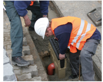
4. Asenna lietelaatikon alle kuormitusluokan vaatima asennusbetoni ja asenna lietelaatikko paikoilleen
