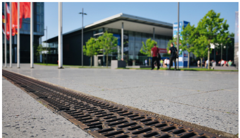
Asennuksen loppuksi voit saumata kourut. Tämä on välttämätöntä, jos kouruihin valuvassa vedessä voi olla maaperää liikaavia aineita.
