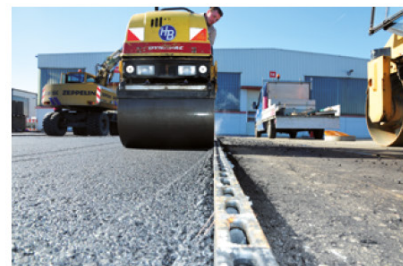
Kourua ympäröivän alueen asfaltointi.
