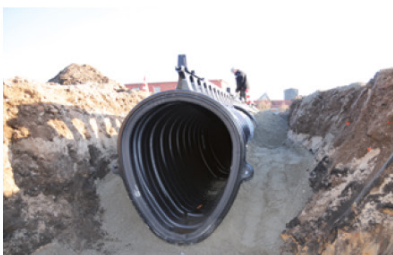
Muna-profiilin ansiosta Qdrainilla on loistavat virtausominaisuudet.
